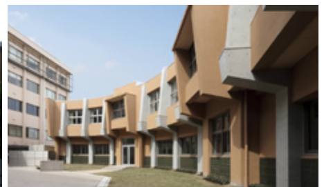
③B棟南立面
